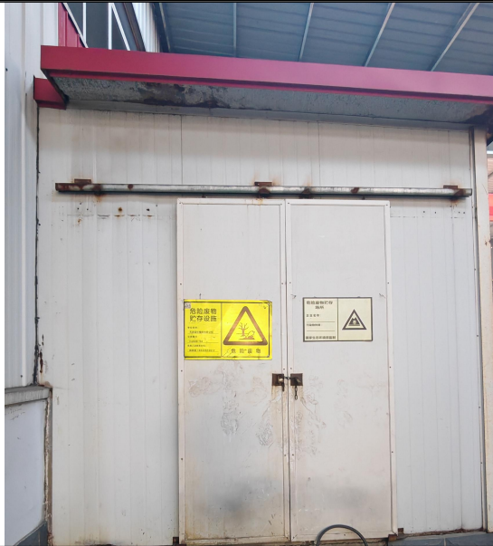
危险废物暂存间
