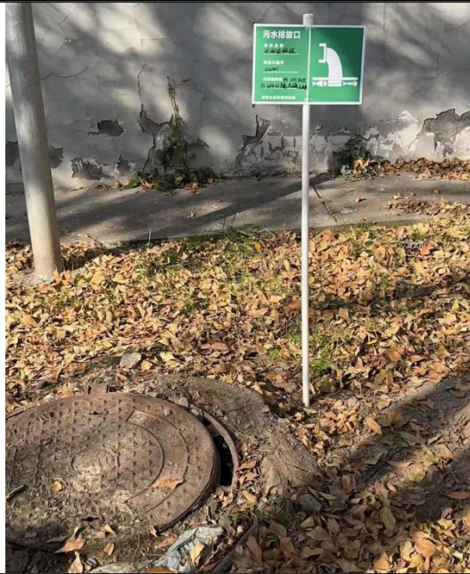
厂区废水总排口及污水排放口规范化标识
