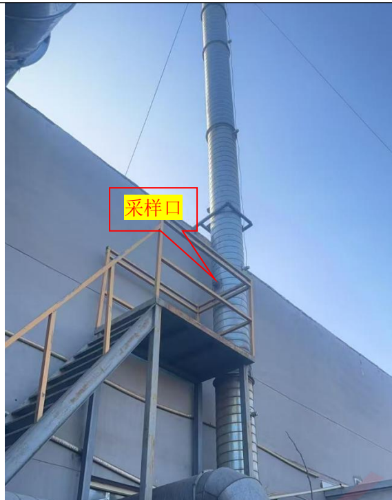
固化废气、燃气废气排放口 P2 (DA002) 采样平台采样口
