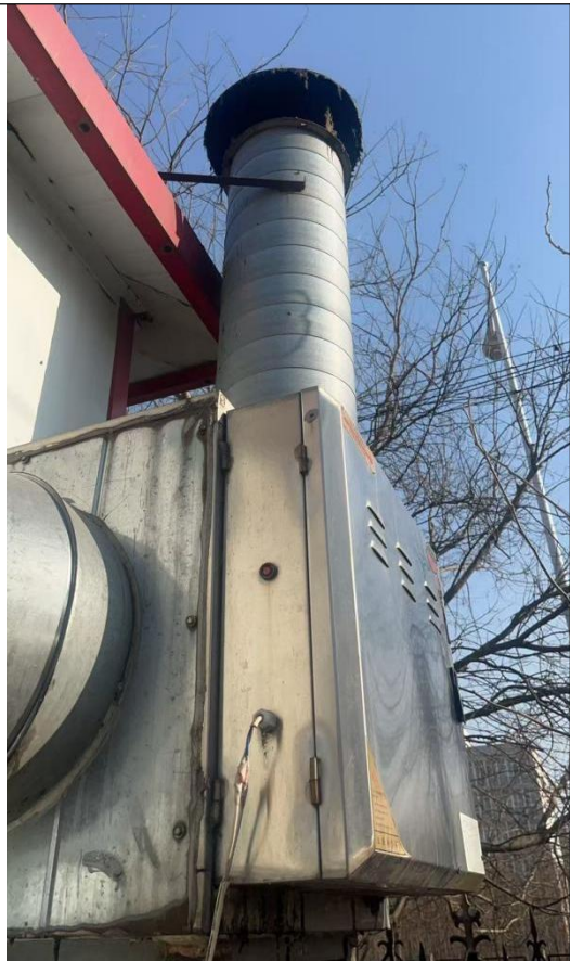
食堂油烟废气排放口 P3 (DA003) 及油烟净化器
