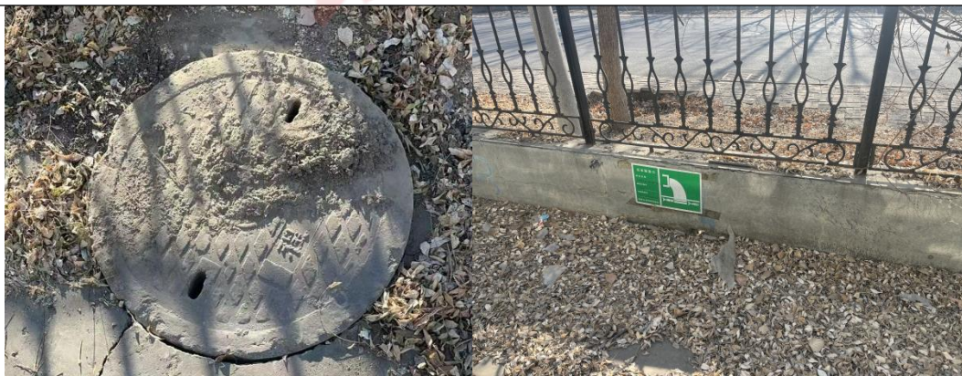
厂区废水总排口及污水排放口规范化标识
