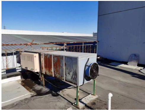
食堂油烟排气筒
