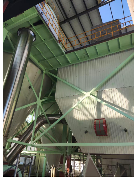
生产车间建设情况
