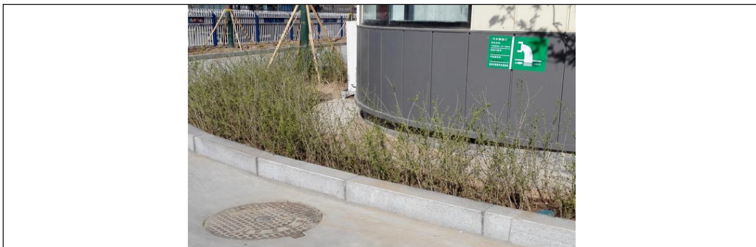
污水总排口及标识牌
