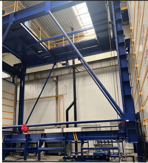
燃气蒸汽发生器排气筒 P27
