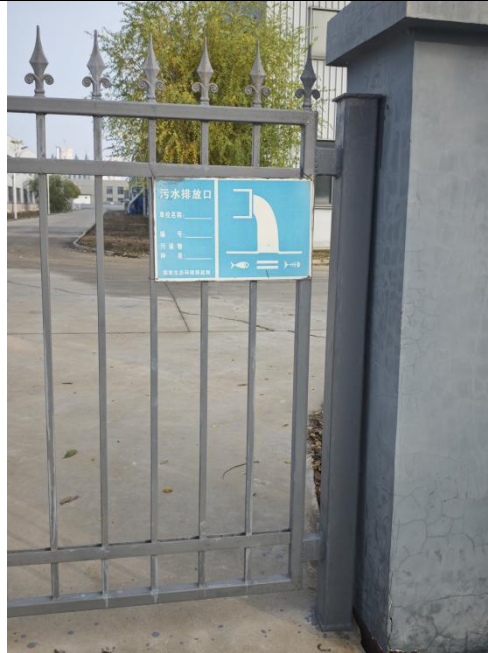
污水总排口及标识牌
