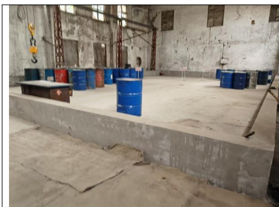
危废暂存间地面及围堰
