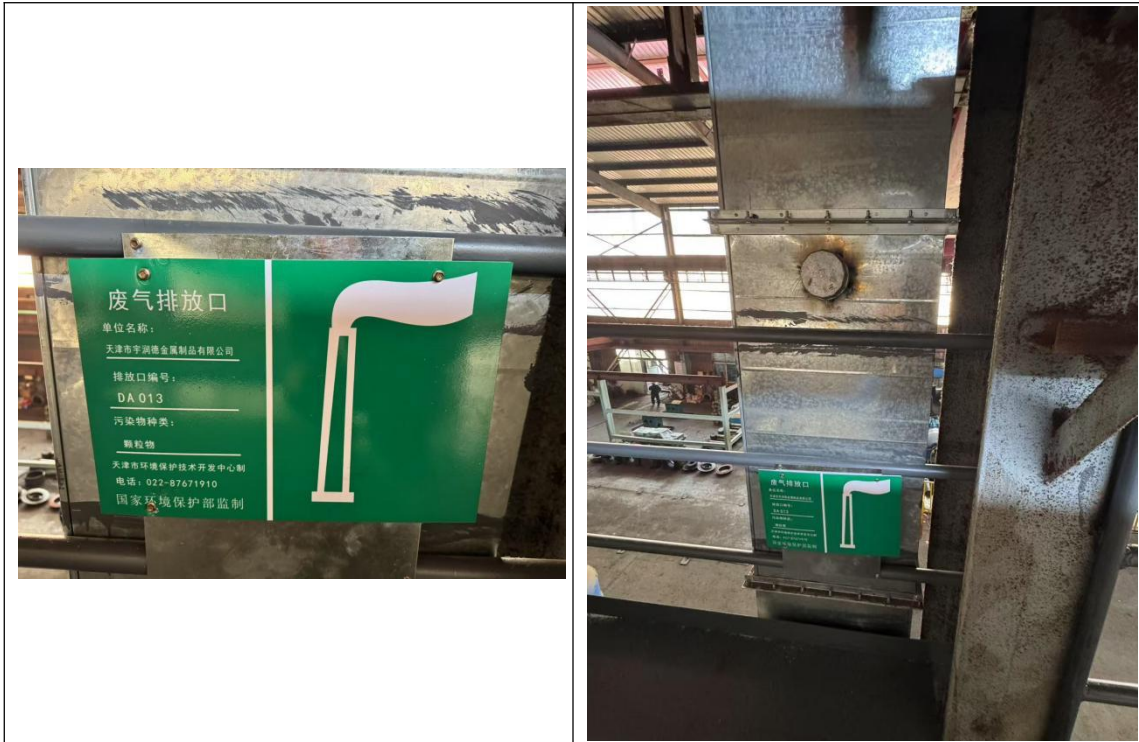
镀锌焊接废气排放口 DA014（实际编号 DA013）
