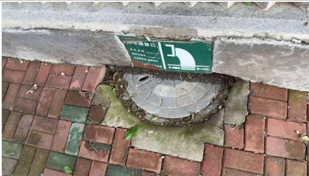
图 3-4 污水总排口及标识牌
