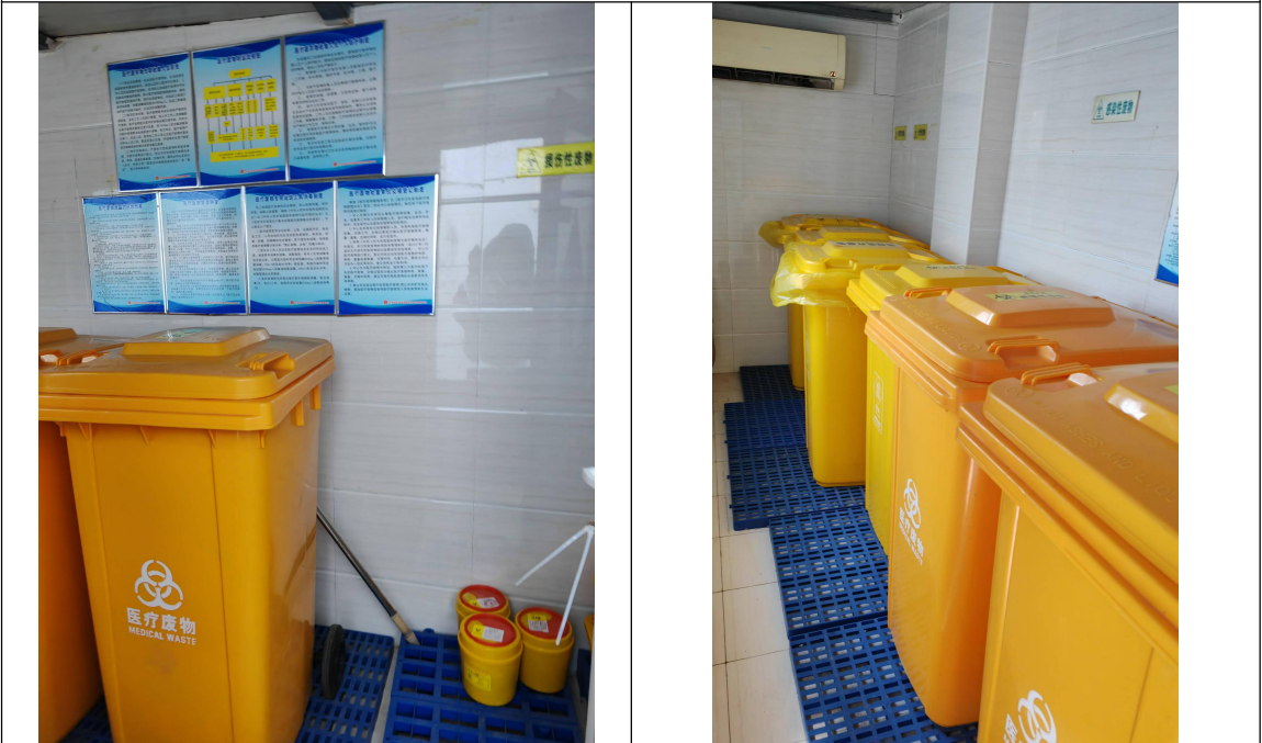
医疗废物暂存间内部
