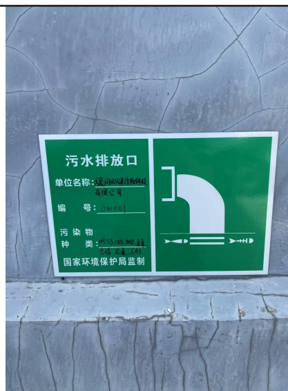
废水排放口标识牌
