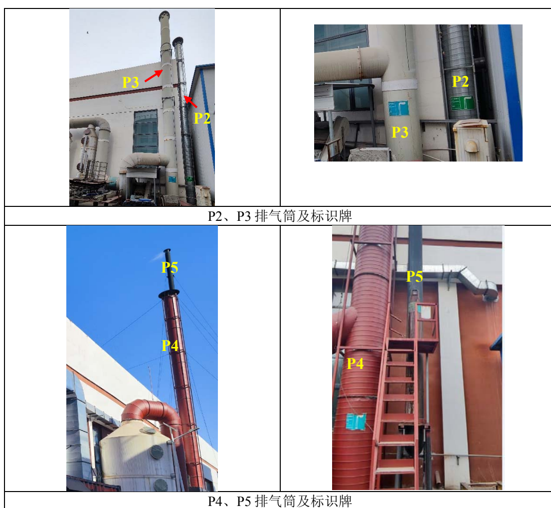
图 2.4-1 废气排污口规范化照片
