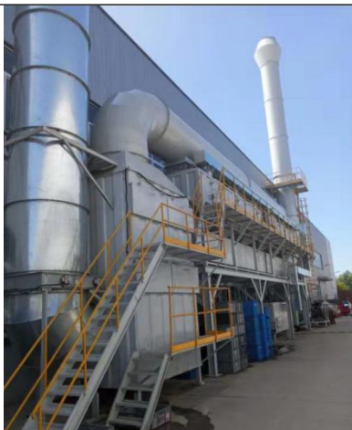
2#有机废气净化设施——“过滤器+活性炭吸附脱附+催化燃烧”——DA002 排气筒及标识牌
