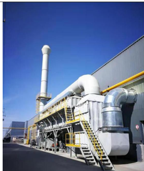
1#有机废气净化设施——“过滤器+活性炭吸附脱附+催化燃烧”——DA001 排气筒及标识牌
